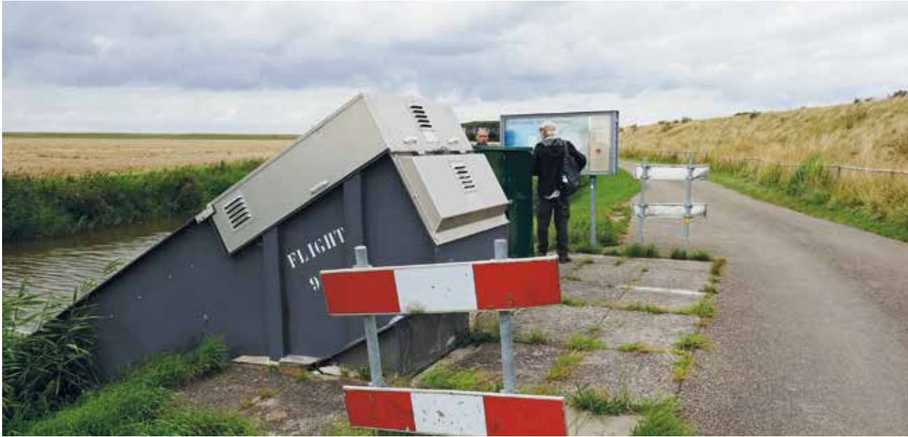
Vispassage met vijzel, om vistrek van en naar de boezem weer mogelijk te maken.
