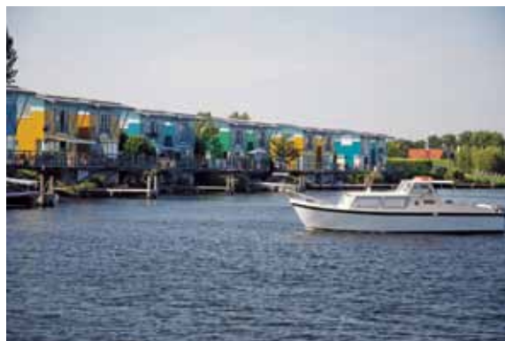
Figuur 1 Overzicht van de 15 experimentele locaties met aangepast bouwen in het rivierengebied. De ingevoegde foto laat een aantal van recreatiewoningen in Maasbommel (nr 5) zien. Als het water in de Maas stijgt migreren de woningen met het waterpeil mee.
